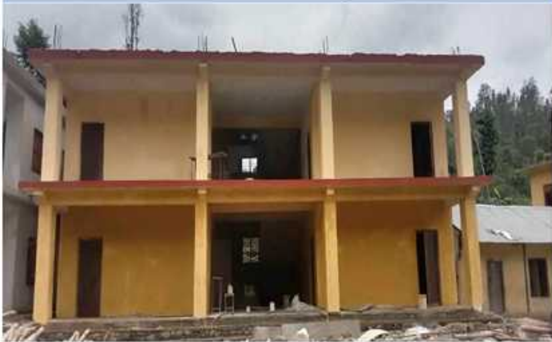
नवनिर्मित ४ कोठे भवन (सरस्वती मा.वि. डुङ्गीखोला, भेरीगंगा-३)
