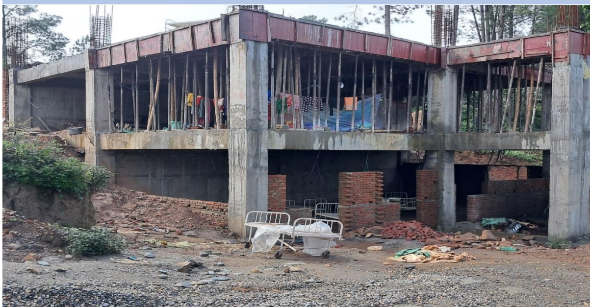
दैलेख जिल्ला अस्पतालको निर्माणाधिन भवन
